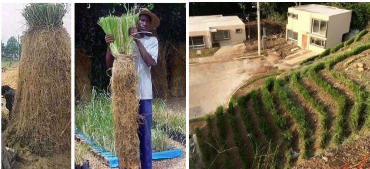
Figura 2. À direita - raízes de vertiver expostas podendo-se notar a grande extensão e densidade das raízes. À esquerda, encosta plantada em linhas com capim vertiver a fim de conter a erosão e promover sua estabilização. Fonte: https://www.capimvetiver.com.br/ e https://poenarco.com.br/2017/04/13/o-fantastico-sistema-vetiver-na-bioengenharia-e-no-meio-ambiente-serie-fatos-fotos-e-videos/
