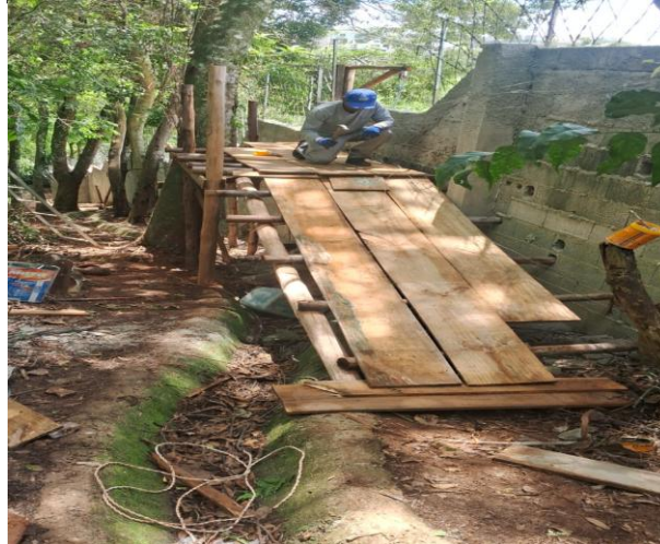
Muro Córrego - Perugia
