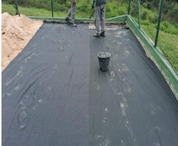
Reforma geral da quadra de areia
