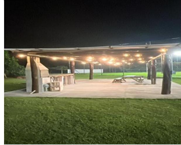
Construção de novos pergolados na área de lazer
