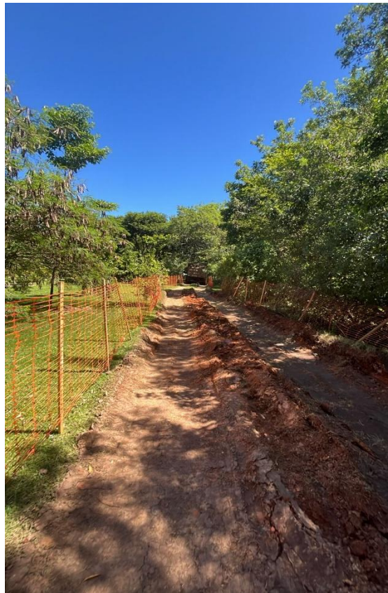
Figuras 10 e 11 – Detalhe de proteção/sinalização das “ruas” utilizadas pelos veículos e máquinas.
