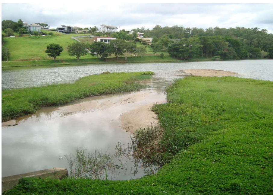
Figura 3 – Depósito de sedimentos natural na margem do lago. Área total analisada 2.448m 2 volume de 2057m 3
