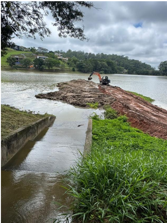
Figuras 6 e 7 – Início das atividades com máquina escavadeira “leve” (esquerda) e Sedimentação para secagem do material do lago (esquerda).
