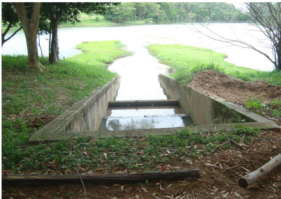
Figura 2 – Escada / dissipador na foz do córrego com reservatórios de contenção de sedimentos.
