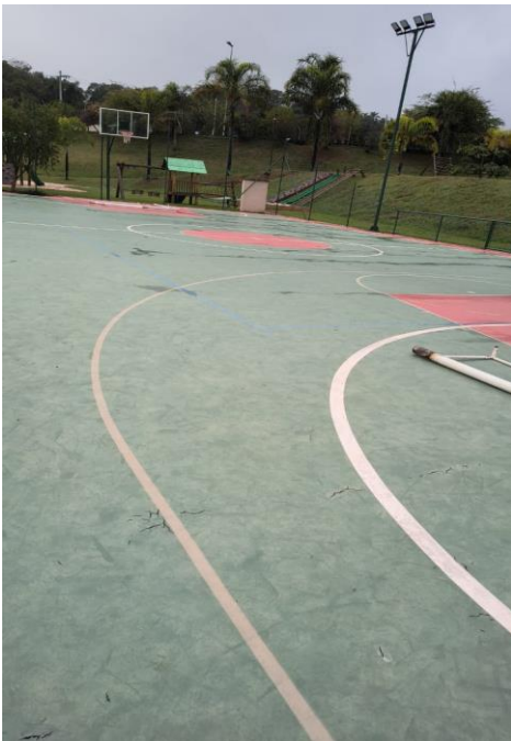
Pintura da quadra poliesportiva:
