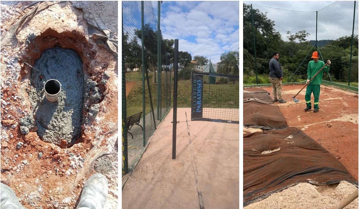
Fixação dos postes e reforma da manta da quadra de areia:
