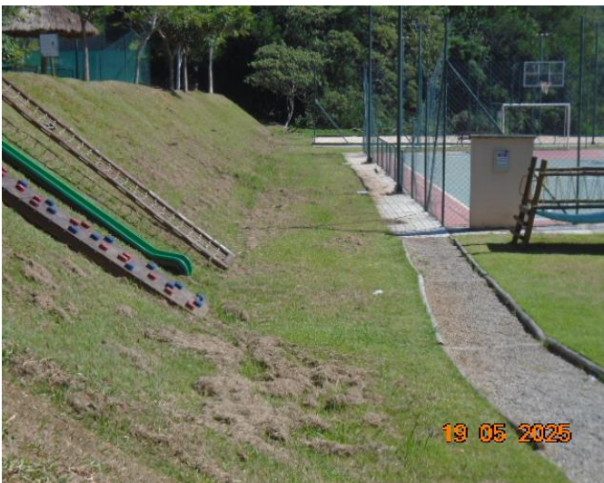
Drenagem e novo bolsão de areia.
