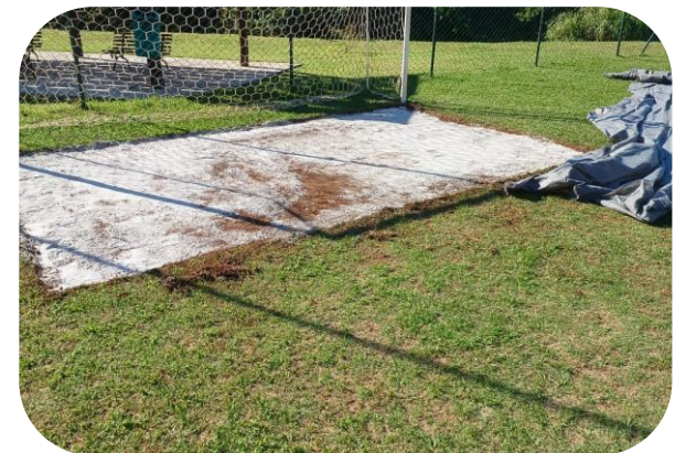
Regularização do local
