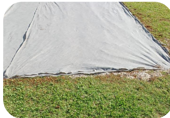
Aplicação de manta geotêxtil
