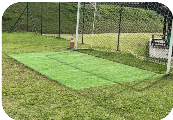
Fixação do tapete de grama Sintética
