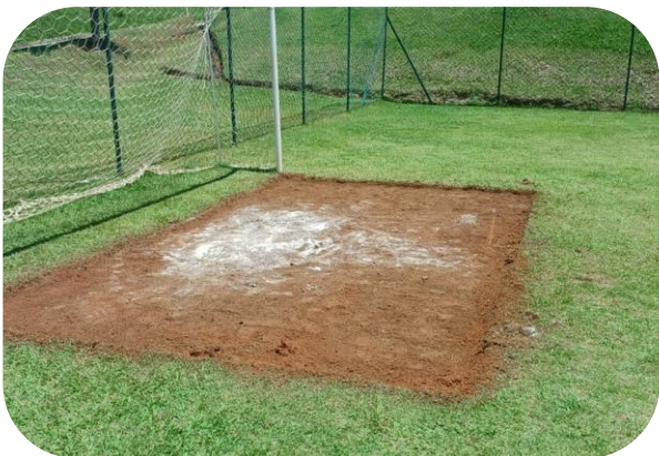
Início dos trabalhos
