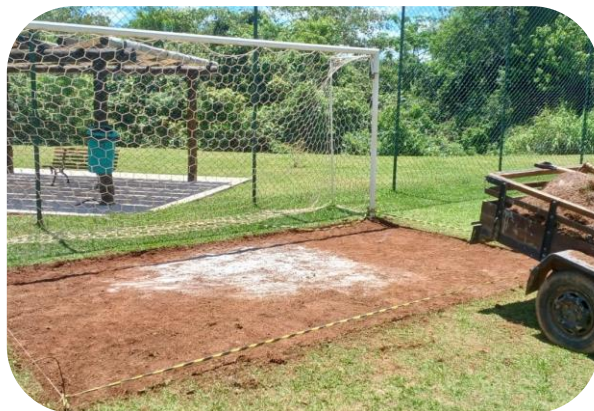
Início dos trabalhos
